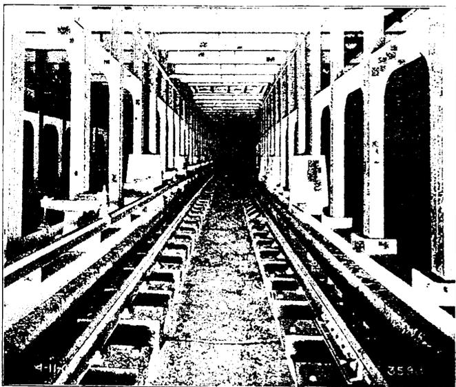
Die für die Schnellbahngleise gewählte Ausführungsart des Oberbaues vereinigt den Vorteil elastischer Gleislage mit dem als vorteilhaft empfundenen Fortfallen der Steinschlagbettung, die in allen Stadtbahntunneln überaus stark verschmutzt. Namentlich in den Haltestellen gibt gewöhnliche Steinschlagbettung, die sich rasch mit einer Staub- und Öl-Schicht überzieht und nicht mehr genügend entwässert, zu Klagen Anlaß.
