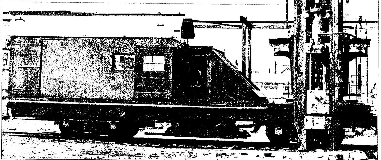
der Läufertruten angebrachten Drehzapfen angeordnete Bärfführung an einem Traggestelle befestigt ist. Eine aus Schraube mit Kurbel bestehende Vorrichtung dicht unterhalb des Drehzapfens dient dazu, die Läufertruten der Quere nach schräg zu stellen (Abb. 2, Taf. XIII), um schräge Dampfpfähle einzurammen. Die Hebe- und Senk-Vorrichtung des Läufertrutengerüsts wird vom Traggestelle aus betätigt. Das Gerüst ruht auf zwei Rollenlagern
