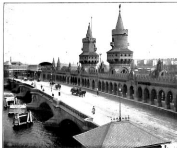
Abb. 3. Überführung der Hochbahn über die Oberbaumbrücke. Im Hintergrunde Haltestelle Warschauer Brücke.
