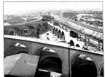
Abb. 2. Das Anschlußdreieck (im Bau). Rechts im Hintergrunde Überführung der Hochbahn über den Potsdamer Bahnhof.
