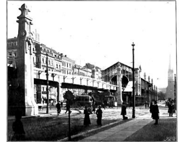
Abb. 5. Haltestelle Bulowstraße und Überbrückung der Potsdamer Straße.
