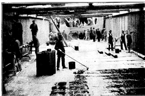
Abb. 3. Dichtungsarbeiten im Tunnel und Beseitigen der vorläufigen Abschlußwand in der Taubentzenstraße.
