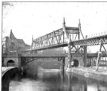
Abb. 1. Überführung der Hochbahn über die Anhalter Bahn und den Landwehrkanal. Im Hintergrunde das Krafthaus.
