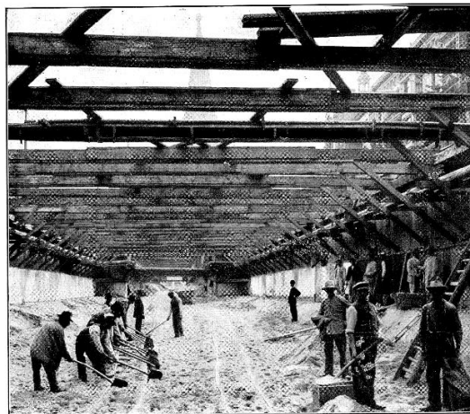
Abb. 2. Absteifung der Baugrube für die Haltestelle Zoologischer Garten.
