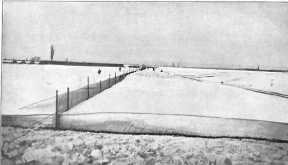
Abb. 3. Schneablagerungen an einem Zaune mit 15 cm weiten Schlitzten.
