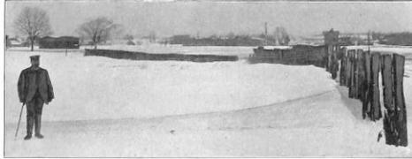
Abb. 9. Schneablagerungen an einem Zaune mit 5 cm weiten Schlitzten.
