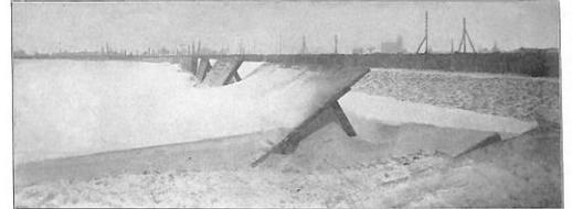
Abb. 3. Ablagerung vor und hinter einer unter 75° gegen das Gelände geneigten Wand nach dem Schneetreiben vom 2. Februar 1901.
