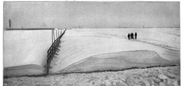
Abb. 5. Schneablagerung an einem Drahtzaune mit 6 mm Maschenweite.
