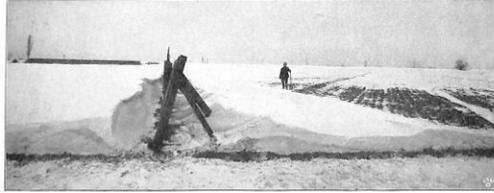
Abb. 4. Ablagerungen vor und hinter einer unter 75° gegen das Gelände aufgestellten dichten Wand nach dem Schneetreiben vom 23. Februar 1901.
