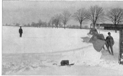
Abb. 7. Flankendeckung eines Einschnittes.
