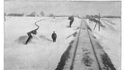
Abb. 1. Schneablagerungen an einem Zaune mit 5 cm weiten Schlitzten.
