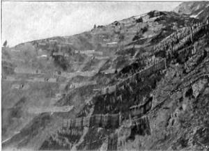
Abb. 7. Lawinenschutzbauten am Blasegg oberhalb Langen am Arlberg.
