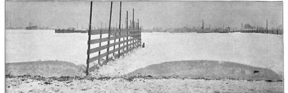
Abb. 4. Schneablagerung an einem Drahtzaune mit 9 mm Maschenweite.
