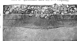
Abb. 7. Querschnitt nach der 3ten Stopfung.
