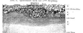
Abb. 8. Querschnitt nach der 5ten Stopfung.
