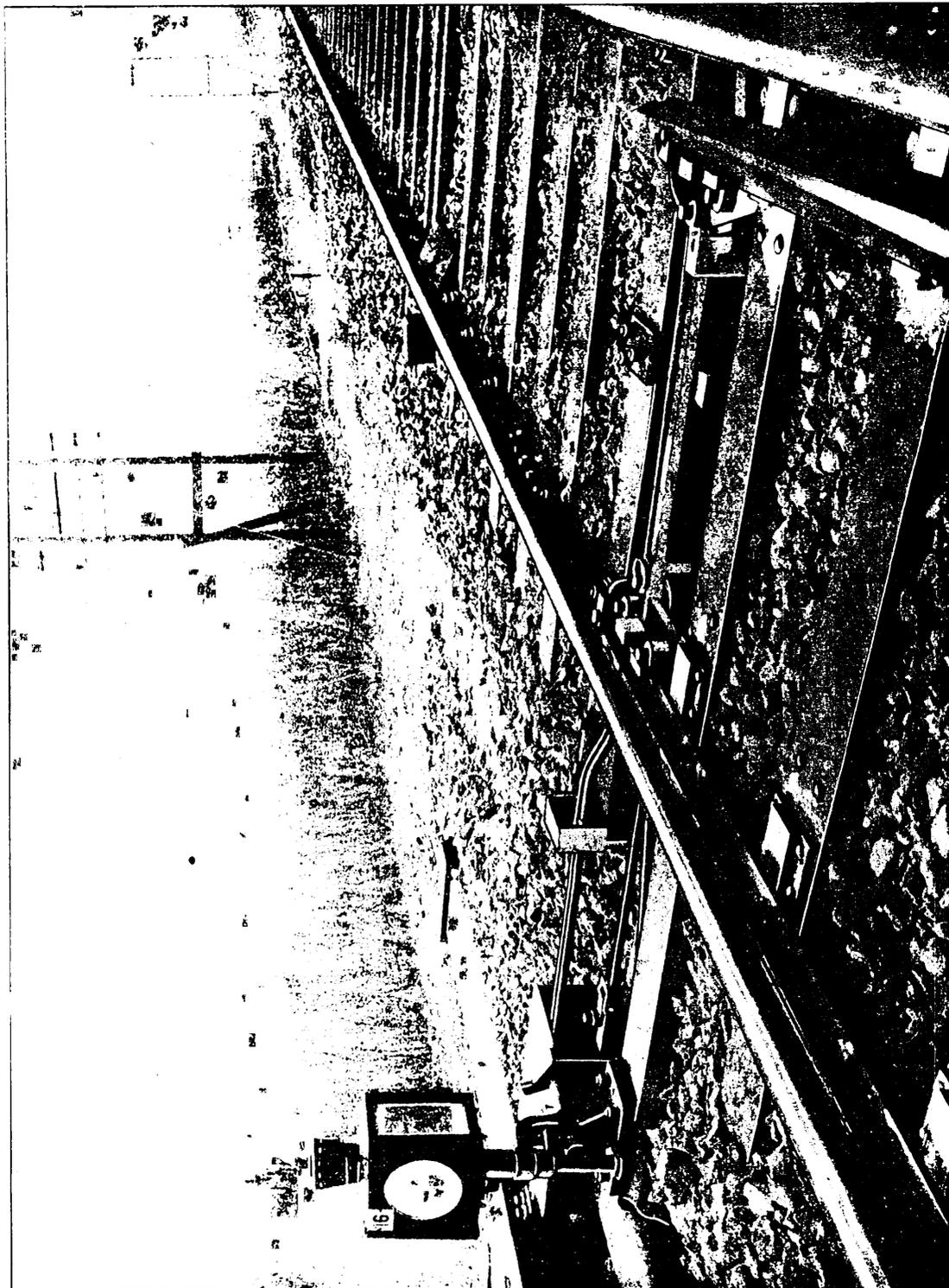
Weichenbocks aufzusetzen und mit der Anschlußlasche zu verschrauben. Diese Arbeit ist in wenigen Minuten auszuführen. Soll die Handstellung längere Zeit in Benutzung bleiben, so ist auch das Gewichtstück auf den Handstellhebel aufzusetzen; bei kurzer Benutzungsdauer reicht der Stellhebel ohne das Gewicht aus (siehe Anm. auf folg. S.).
