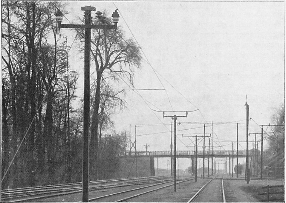
Bild 29. Sektionsafbrott vid Oerlikonledning.
