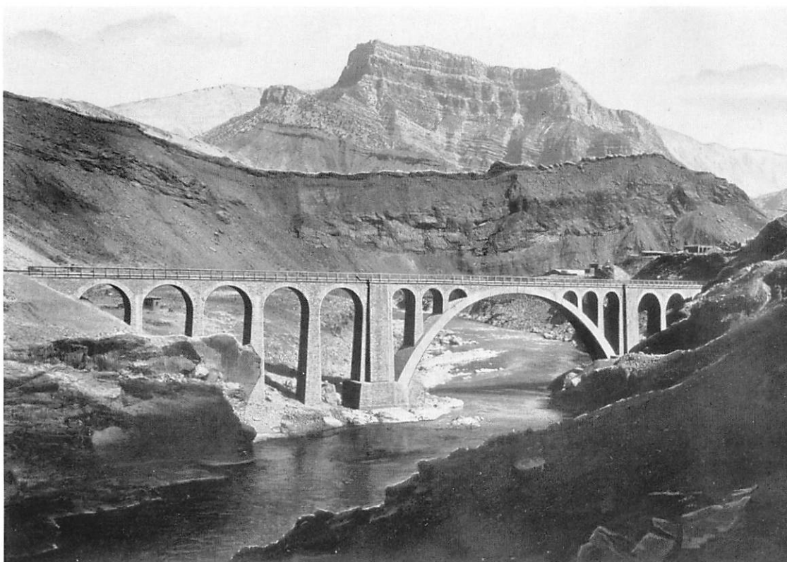
Ein Viadukt auf der transiranischen Bahn.
