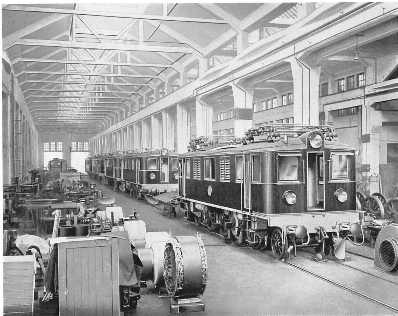
Elektrische Lokomotiven bei der Montage.
