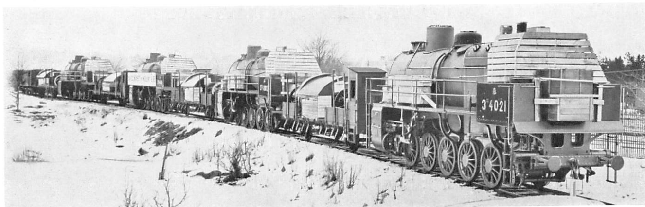
Transport von Lokomotiven für U.d.S.S.R. auf besonderen Rädern. Transport of locomotives for U.S.S.R. on special wheels. Transport de locomotives pour l'U.R.S.S. sur des roues spéciales.
