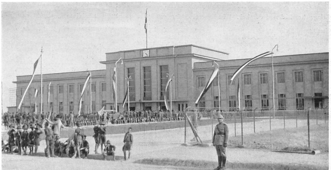
Der Bahnhof in Téhéran. — The station in Téhéran. — La gare de Téhéran.
