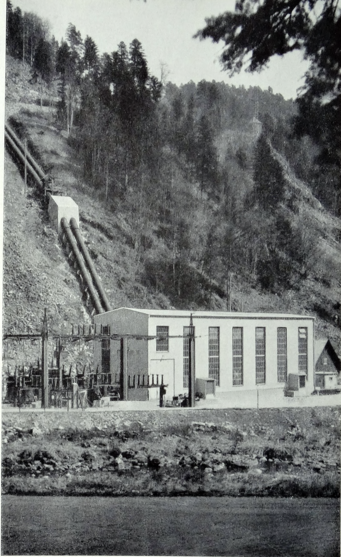
Vista general de la central de Eichholz
