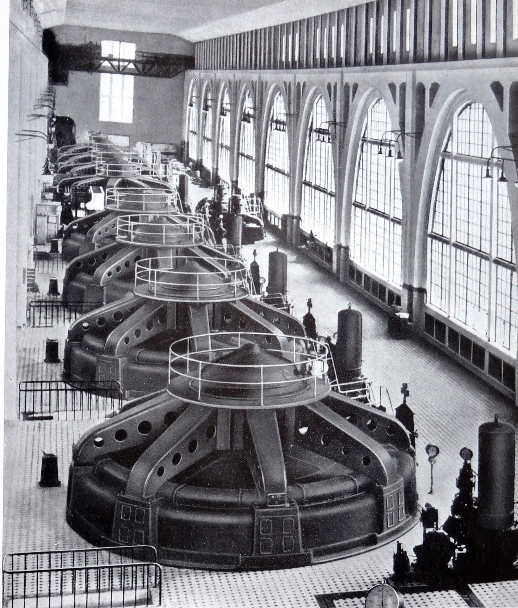
Interior de la sala de máquinas
