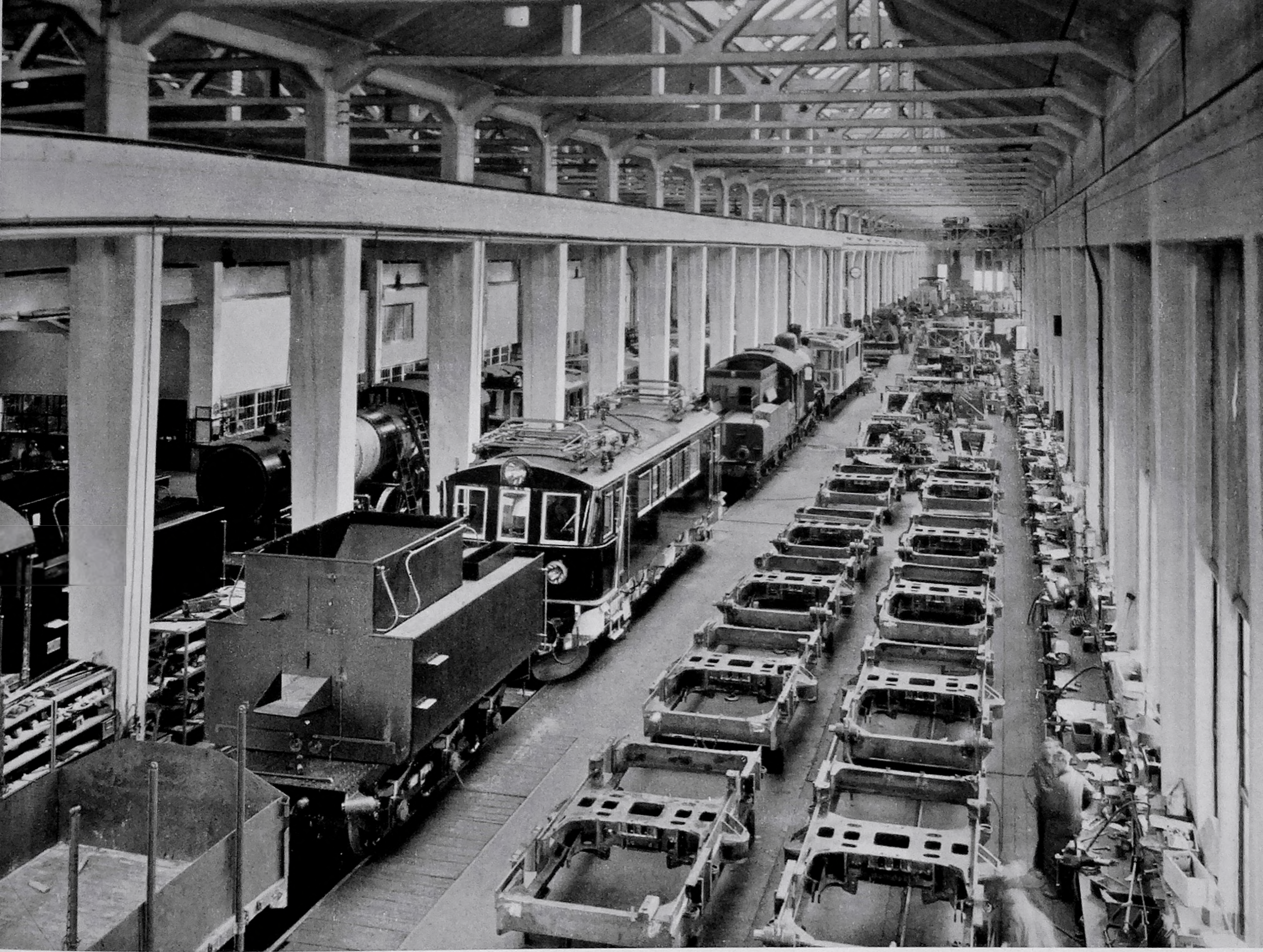
Una sección de los talleres de montaje para locomotoras
