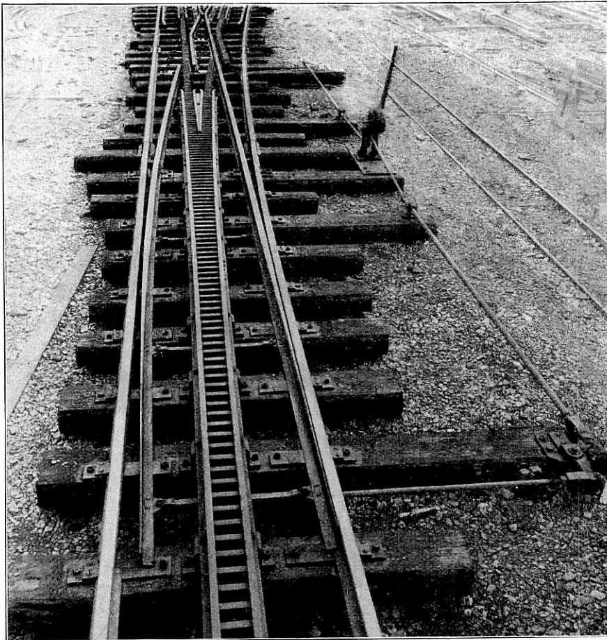
Abb. 146. Zahnstange Riggenbach.
