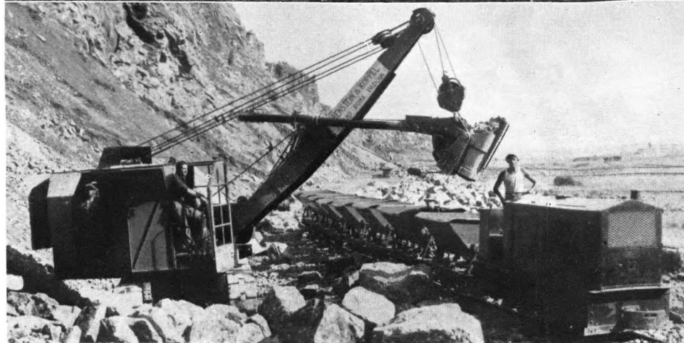
Fig. 18954 Typ L 3. Höjdgrovare arbetande i hård mark.
