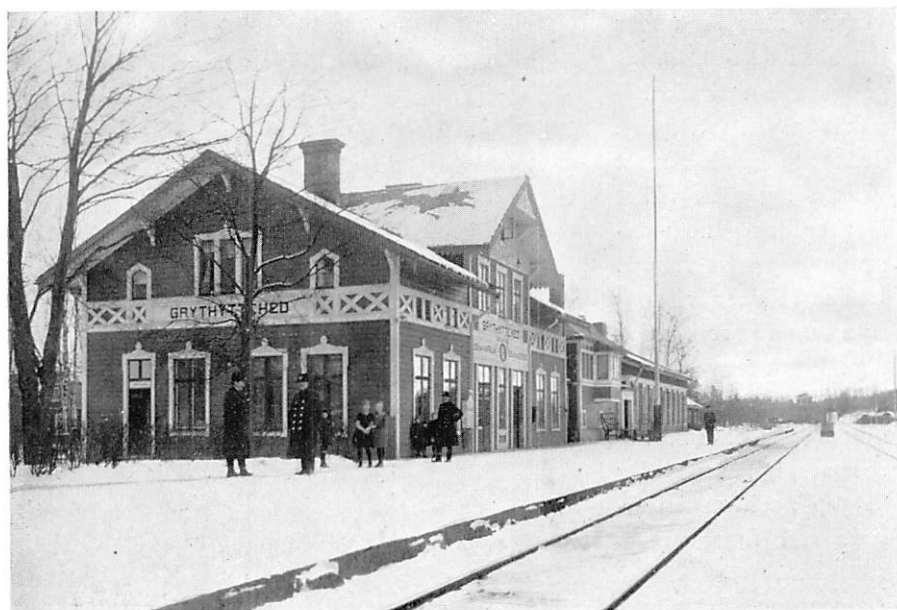
Fig. 47. Grythyttedens stationshus, sammanbyggt med ställverk.
