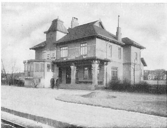
Fig. 48. Älvängens stationshus med inbyggt ställverk.
