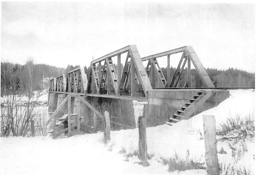
Fig. 29. Bro över Västra Klarälven.
