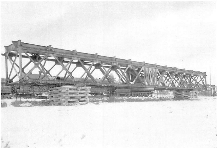
Fig. 20. Gamla svängspannet till bro över Byälven.
