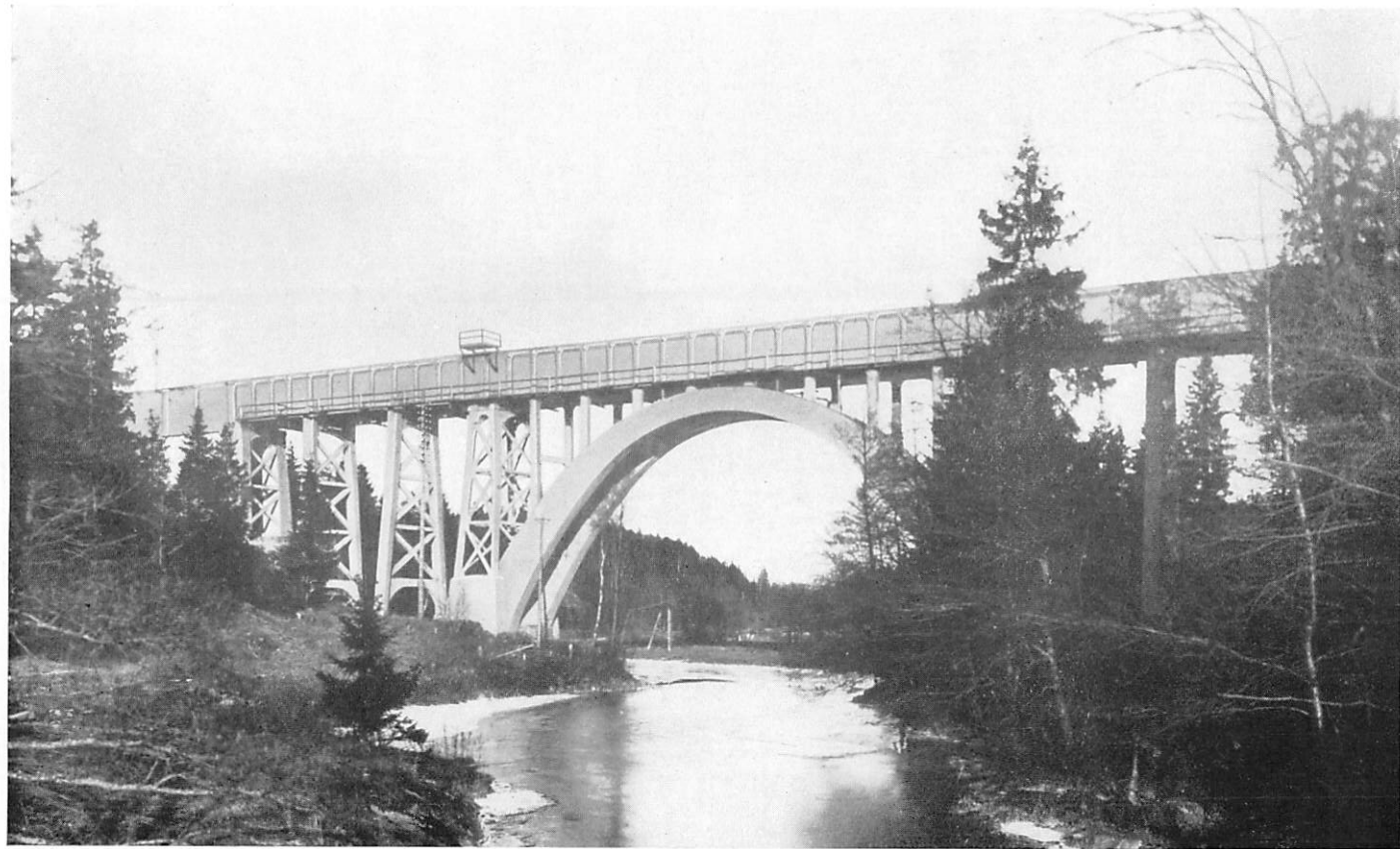
Fig. 23. Bro över Storån (Velanda), efter ombyggnad.
