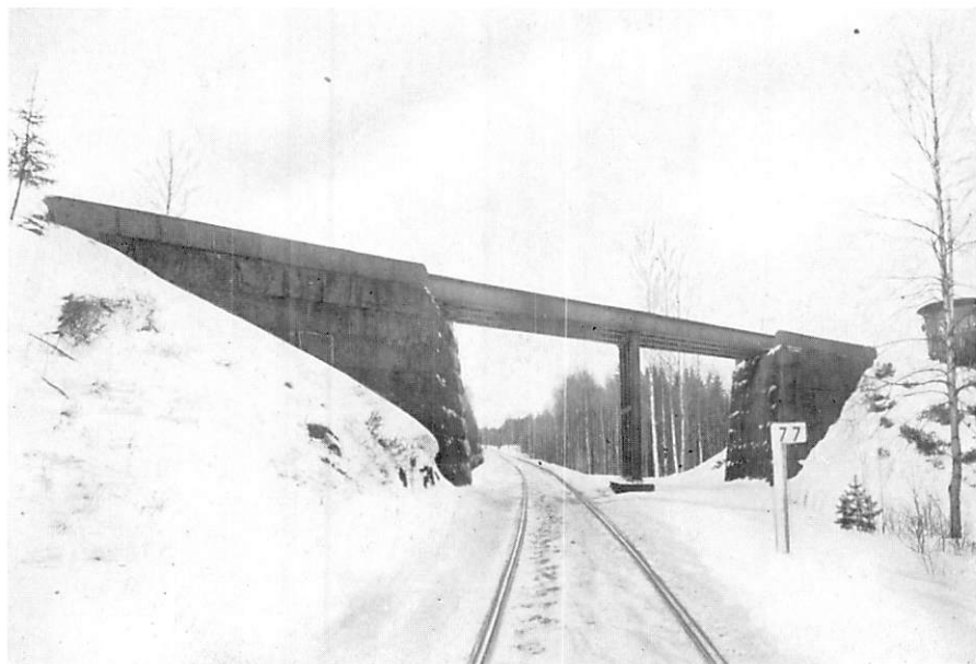
Fig. 31. B. J. viadukt över F. L. J.
