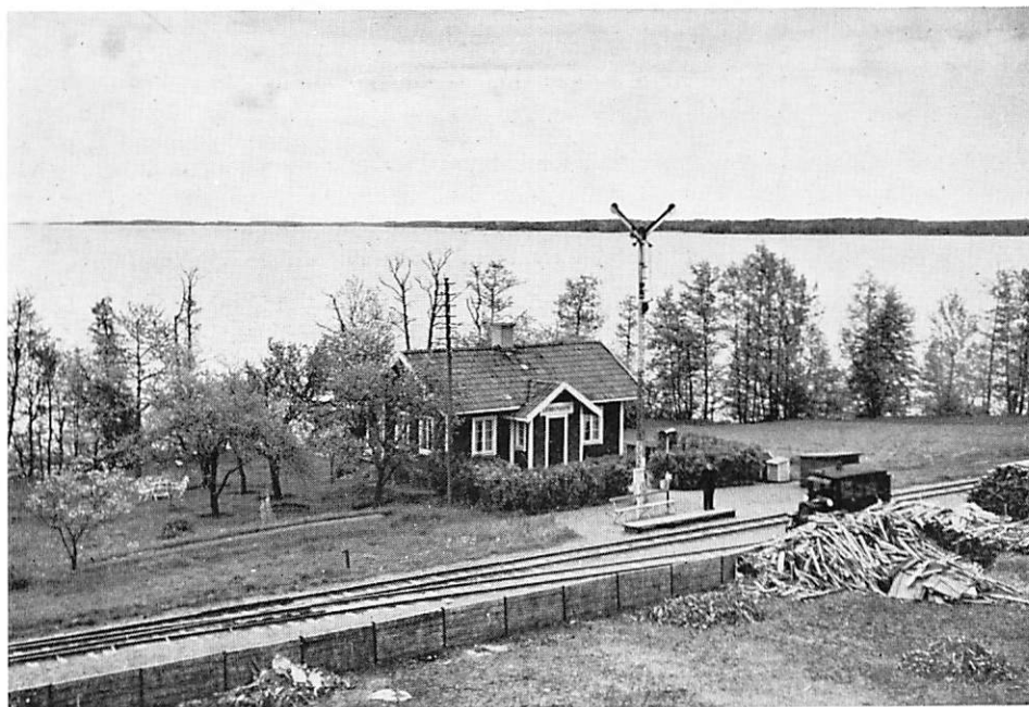
Lenbergsviks hållplats och vaktstuga.
