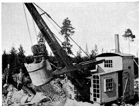
GRÄVMASKIN I ARBETE.
