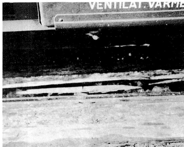
Sönderkörd plankvandring vid vänster räls
