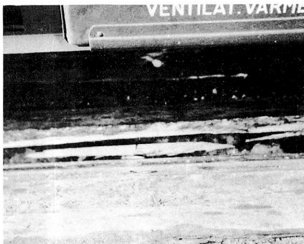
Sönderkörd plankvandring vid vänster räls
