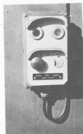
Fig 92 Manöverdon för A-signal, nyare typ
