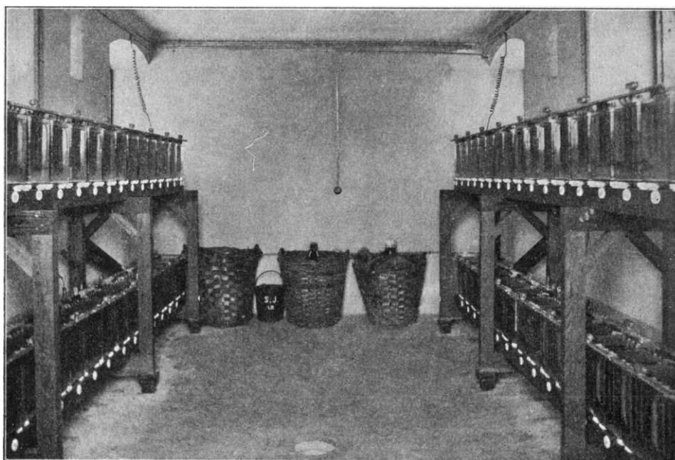
Bild 132. Accumulatorbatteri, inrymt i undre våningen till ett ställverkshus.
