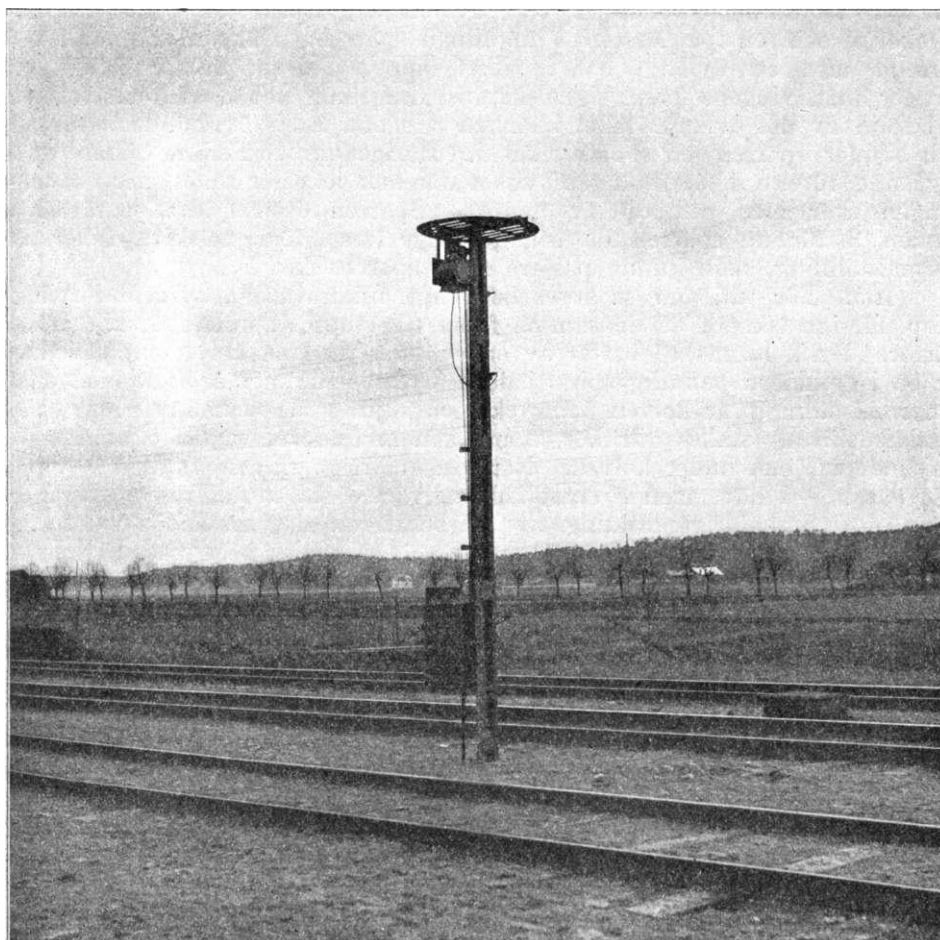
Bild 144. Försignal med elektr. drivanordning.
