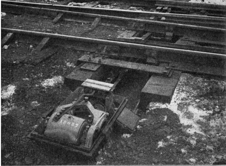
Bild 137. Elektr. drivanordning vid dubbel korsningsväxel.
