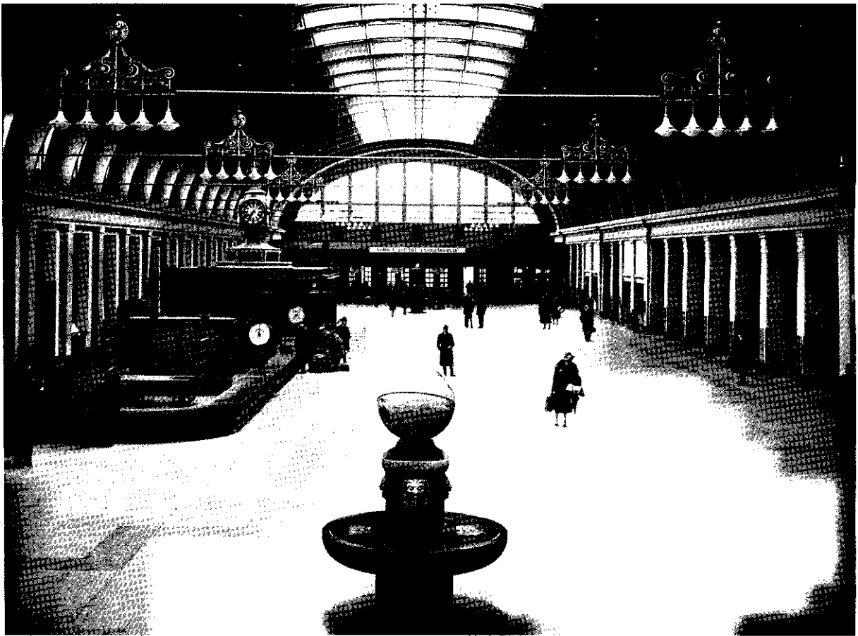
Vänthallen sedd från terrassen.
