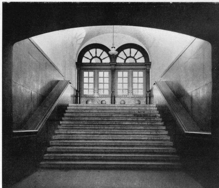
Uppgång från persontunneln till södra utgångshallen.
