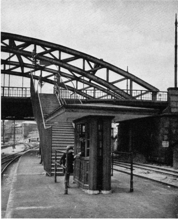
Trappan till Kungsgatan.
