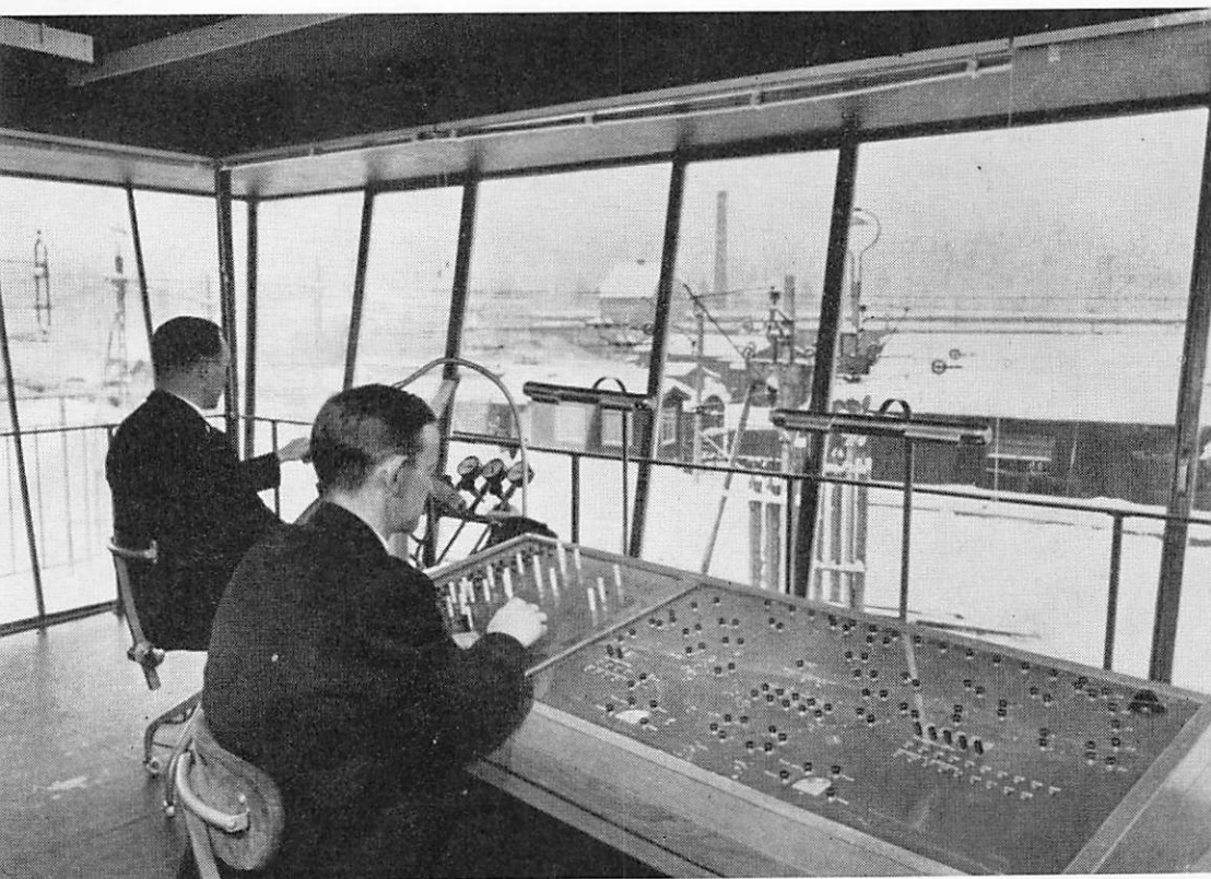
Bild 4. Interiör av Ånge rangertorn, rangerorgan för skenbromsar till vänster, samt manöver- och indikeringsorgan till höger.
