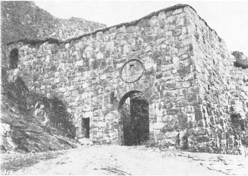
Fig. 2. Blockbusporten under framgrävning. Konserveringen har påbörjats, till höger på bilden. Porten har återställts. Muren har en gång varit c:a 3 m. hög.
