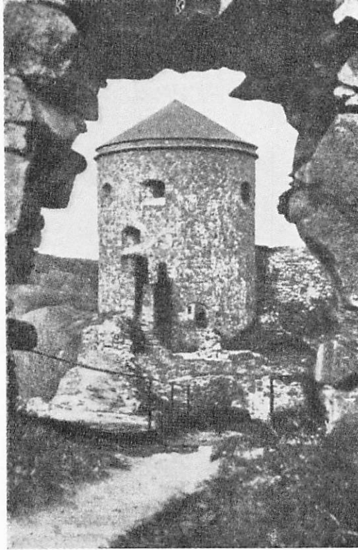
Fig. 3. Bobus ruin. Fars hatt sedd från muröppningen i Mors Mössa.
