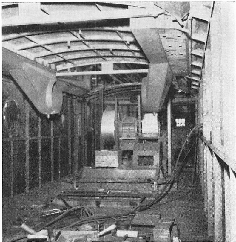
Fig. 13. Korg under montering, interiör.
