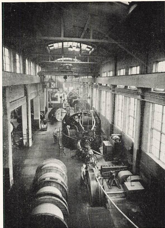
Fig. 4. Interiör från kraftkabelfabriken, kontinuerlig blypress.
