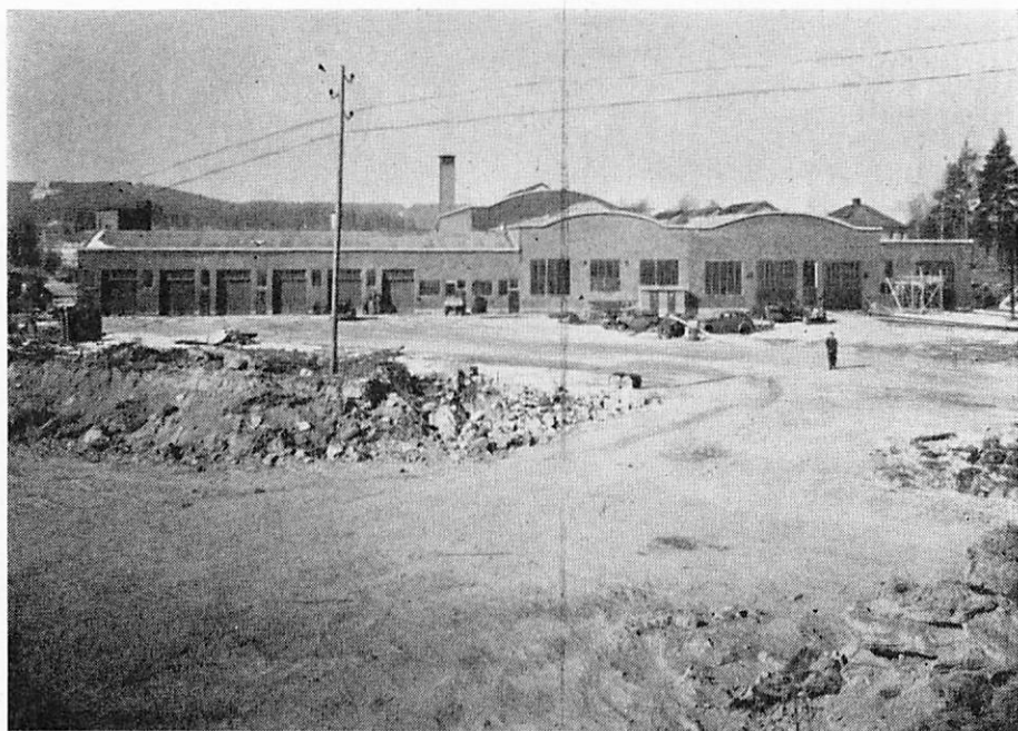
Fig. 2. Fasad mot öster. Den låga delen till vänster är motorverkstaden. De högre partierna äro förråd och vagnverkstad.
