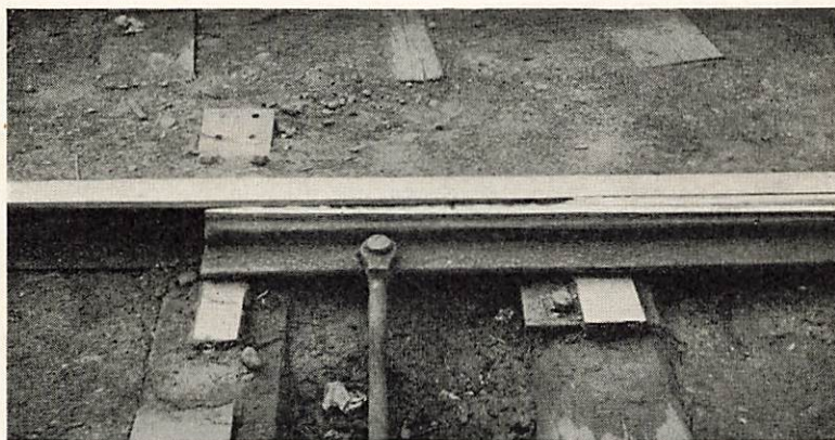
Fig. 1. Växeltunga med stödräl före påsvetsning.
