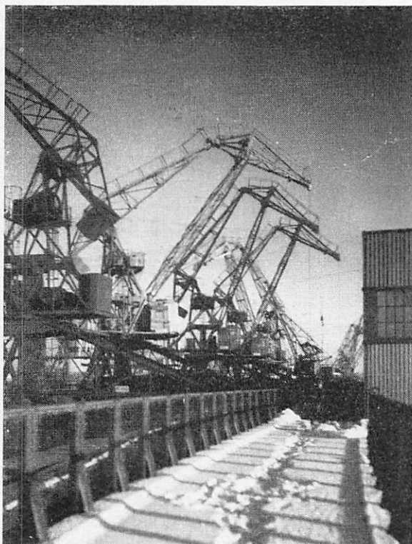
Fig. 21. Moderna vipparmskranar i arbete i Frihamnen.
