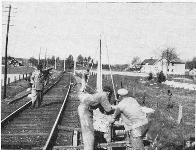
Fig. 12. Resning av strängbetongstolpe.
