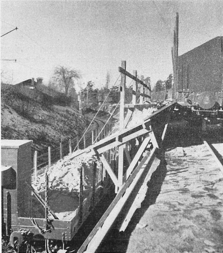
Fig. 3. Omlastningsbrygga vid Stockholms Östra, sedd från banken.
