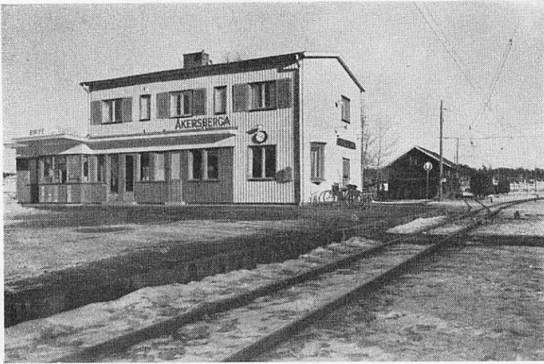
Fig. 3. Exteriör av Åkersberga nya stationshus.
