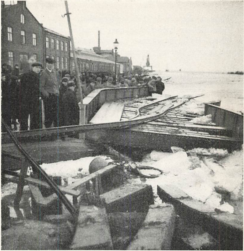
Fig. 18. Fasta spannet på kajen
