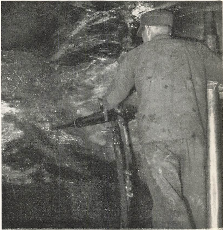
Fig. 5. Borrning med pelarborrmaskin.
