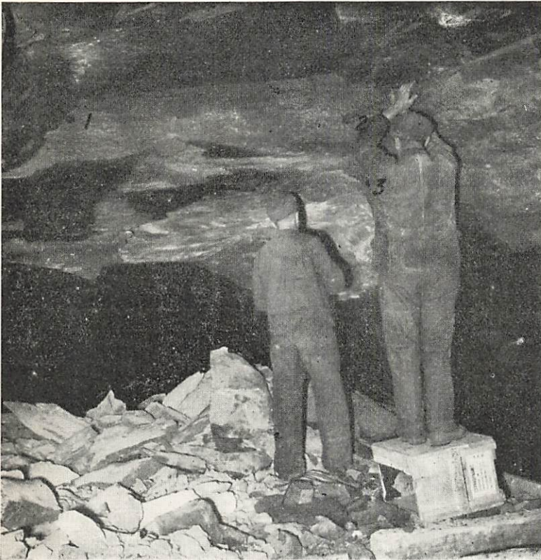
Fig 4. Laddning av borrhålen för sprängning.
