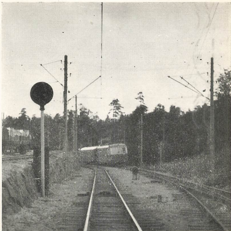
Fig. 5. Linjeutfartssignalen H norrut. Mellan spåren syns baksidan av dvärgsignalen, som tjänstgör som infartssignal vid felsepårsdrift. Längre till höger återfinnes infartssignalen A 1/2.
