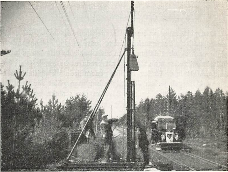
Fig. 1. Pålkran för pålning under kontaktledningsstolpar.
