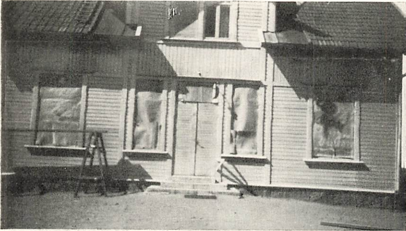
Fig. 1. Täckning av fönster och dörrar.
