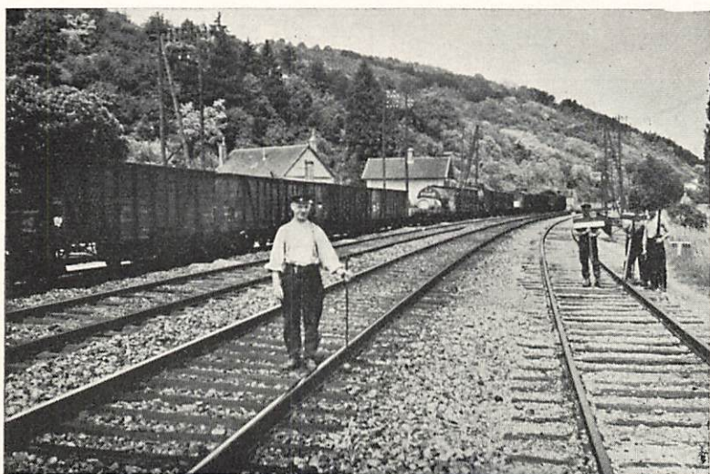
Fig. 16. Kulstång och flukttavlor för soufflage.
