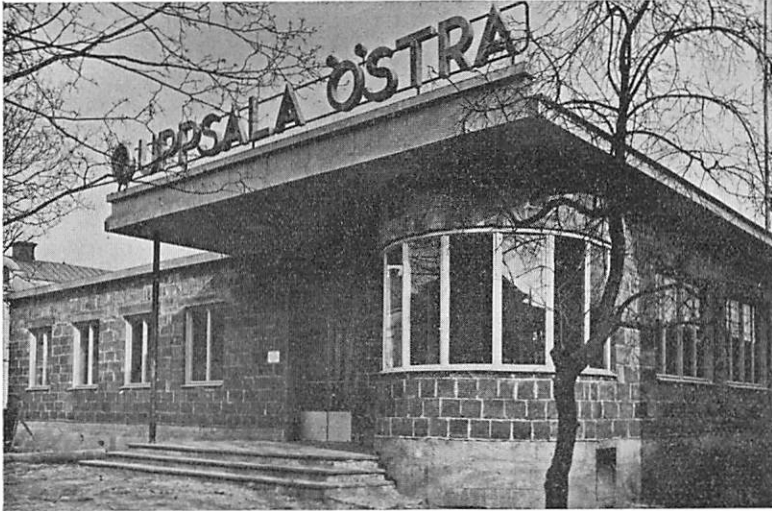
Stationshuset sett från Roslagsgatan.
