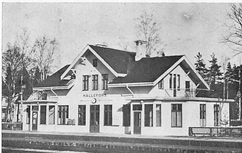
Fig. 8. Hällefors stationshus efter ombyggnaden.
