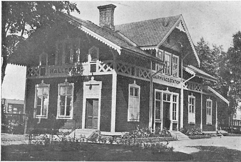
Fig. 7. Hällefors stationshus före ombyggnaden.
