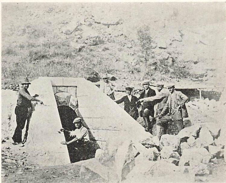
12. Den första färdiga trumman vid arbetena, 2:dra avd. Nord.
