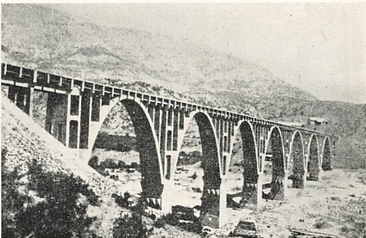
9. Gök-Sou-viadukten av armerad betong, byggd på 8:de avd. Syd.
