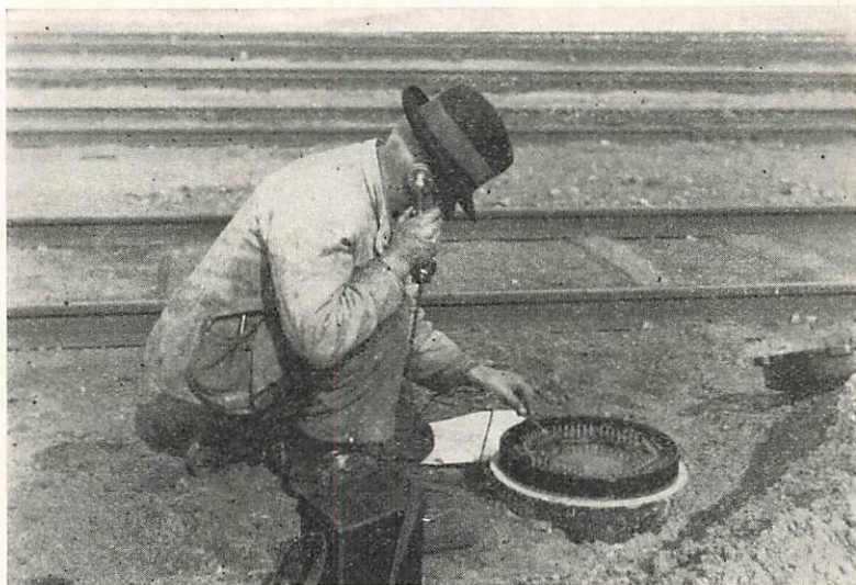
Fig. 16. Kabelförgreningshus.
