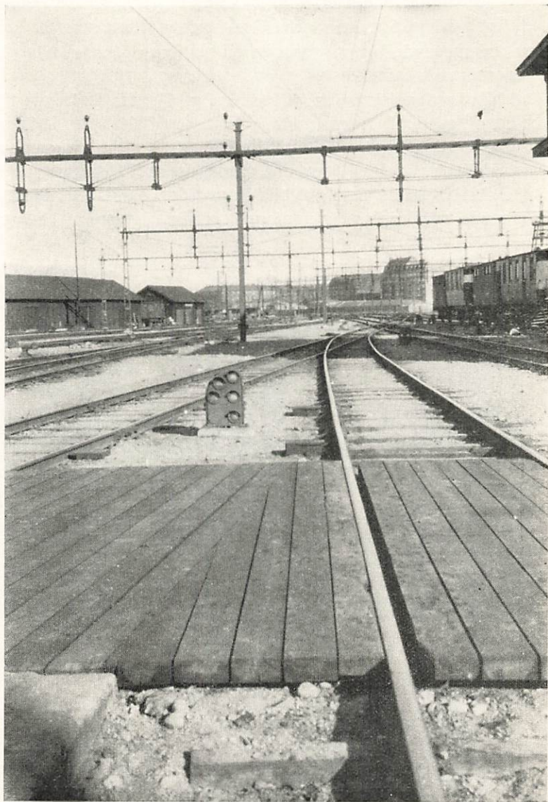
Fig. 9. Dvärgsignal med undre ljusöppning för grönt sken.
