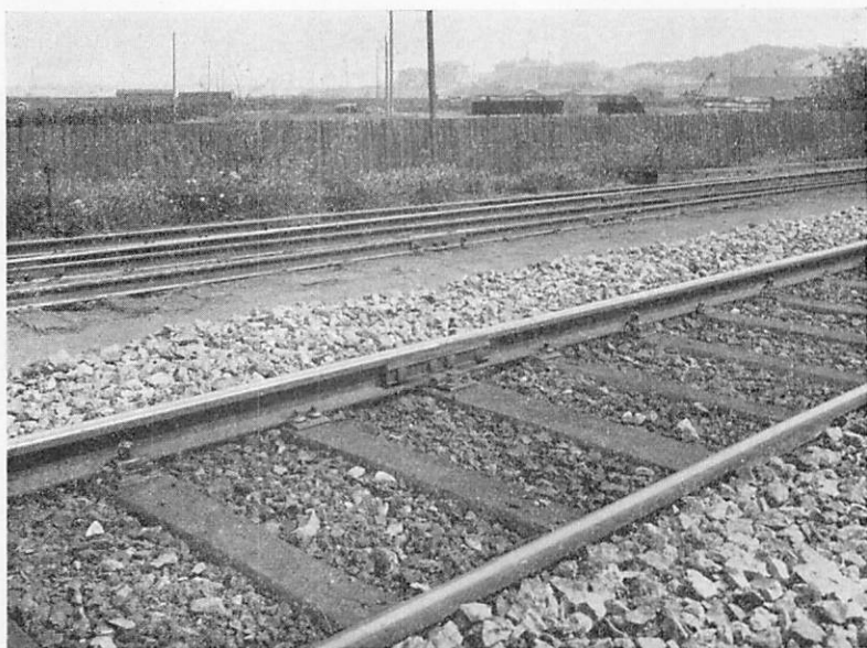
Fig. 7. Svetsad skarv.
