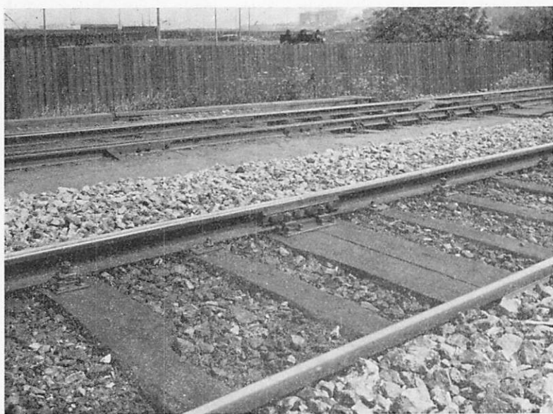
Fig. 8. Expansionsskarv.
